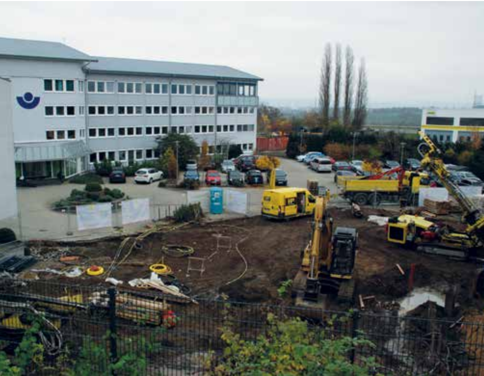
Neben dem bestehenden Präventionsgebäude machen die Bauarbeiten für die neue Sporthalle große Fortschritte. Die Fertigstellung ist für Herbst 2015 vorgesehen.
