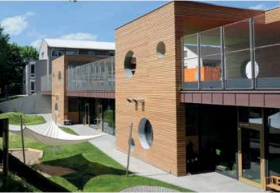
MusterKita: Neubau und im Hintergrund der sanierte Altbau
