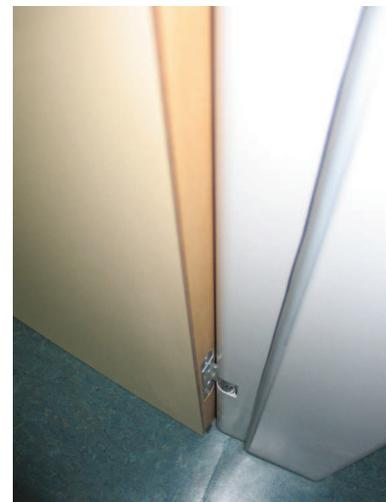
Einige Hersteller bieten bereits Türelemente an, bei denen die Nebenschließkanten systembedingt einen Schutz eingebaut haben. Dies gilt für Zimmertüren ebenso wie für Außentüren. Wir empfehlen, bei Neubauten oder umfangreichen Sanierungen auf solche Systeme zurückzugreifen.
